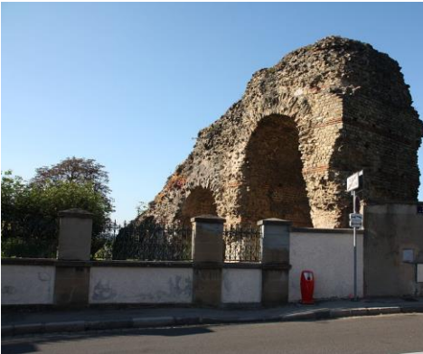
Aqueduc de la Brévenne arrivant rue des Aqueducs.
